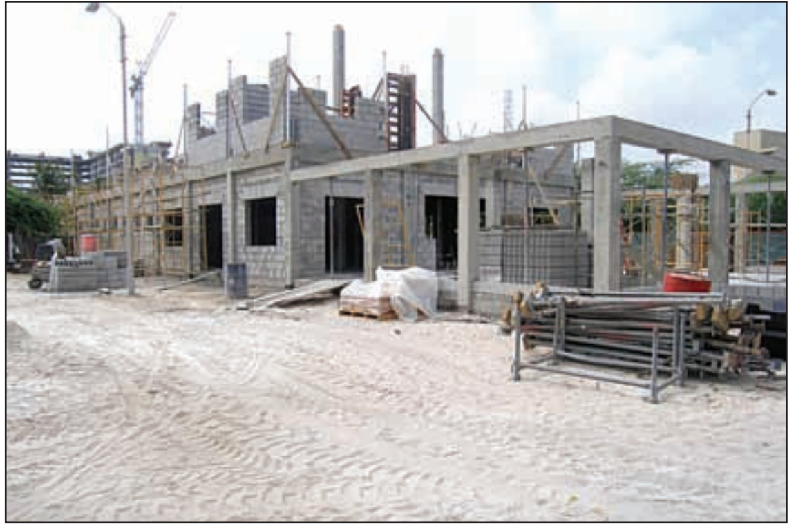
Riba potretnan adhunto por mira e trabounan di construccion riba e Centro di Pesca nobo y un bista di e pier y facilidadnan actual.
